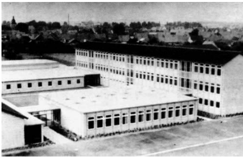
Blick auf die neue Schule von Südwesten
